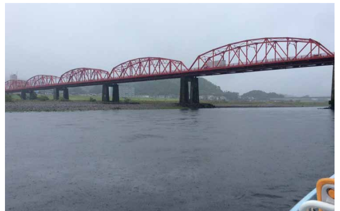
左岸から右岸を望む赤鉄橋と降雨 2022年7月4日午前8時56分
