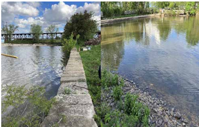
写真1 NBS導入前の直立護岸 2023年5月3日
