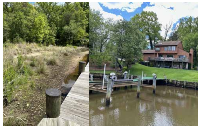
写真2 コンクリート駐車場の一部を活きた海岸線に造成し ボードウォークを設置 2023年5月4日
