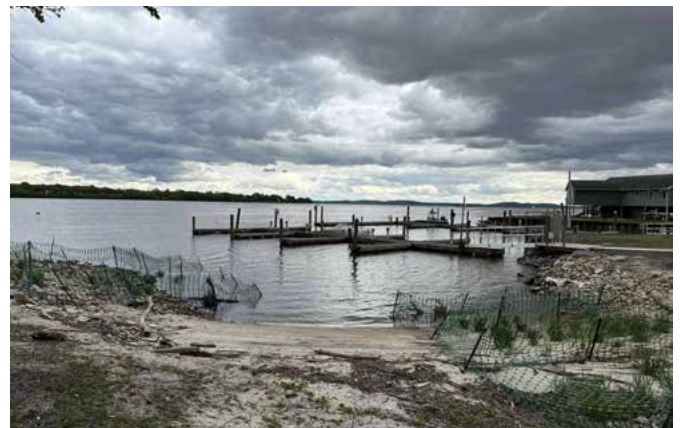
写真3 設置された岬と干潟の一部 2023年5月3日
