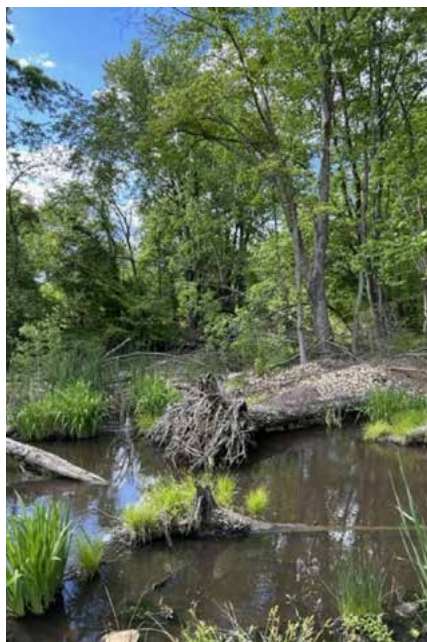
写真1 水路にそのまま置かれた 倒木 2023年5月5日
