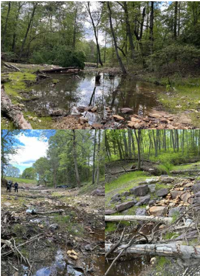
写真1・2・3 RSCによりステップ・プールを造成した小川 ここはUnderwood社の設計による 2023年5月4日
