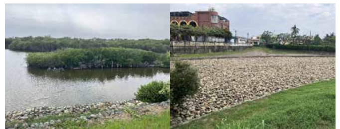
写真3 人工造成マングローブ林と石積み
