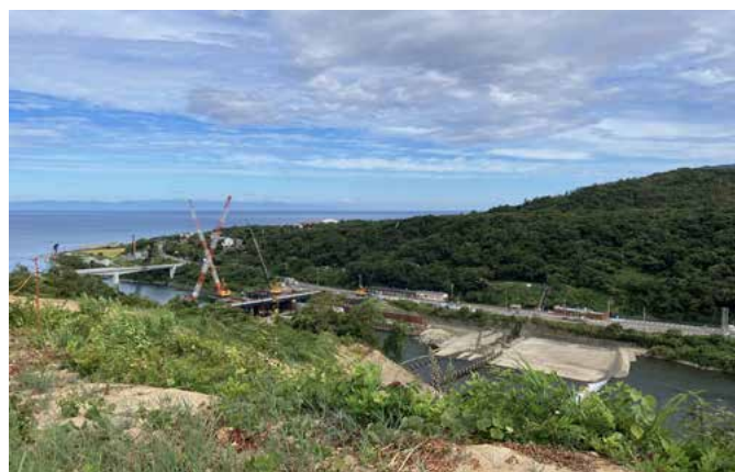
写真9 大河津分水路下流域拡張工事を左岸山腹掘削工事現場から視察 2023年9月4日
