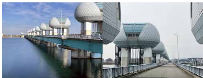
写真13と14 右岸から見た長良川河口堰 2024年3月19日 著者撮影
