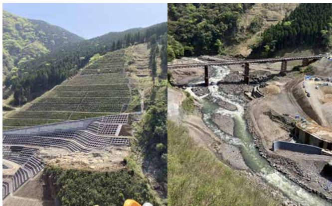
写真5 ダム上流左岸の 山肌掘削と補強 2023年4月17日
