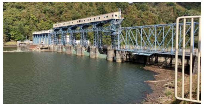
写真8 上田ダムの上流側から見た前景 2023年10月16日
