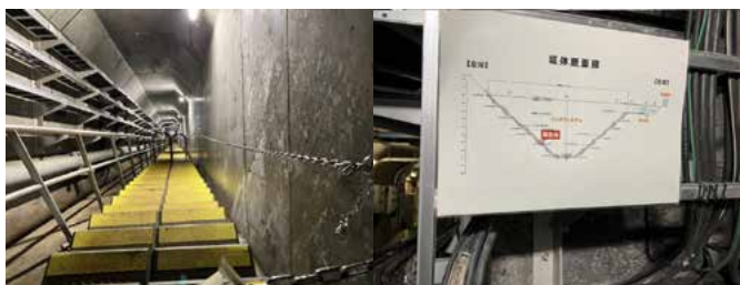
写真6 堤体内126メートル地点から 下を望む 2024年3月18日
