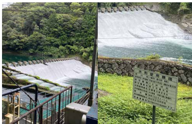
写真7 中平堰 堤体の上を流水する 写真8 中平堰の水利権を説明した札 2023年9月13日 2023年9月13日
