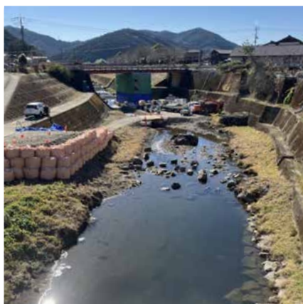
写真10 新開橋付近の工事
