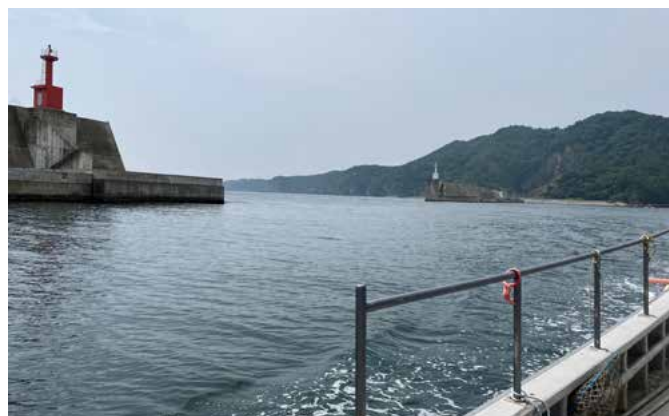
写真2 湾口防波堤の北提内側から湾口防波堤を見る。奥が南提 2023年6月27日
