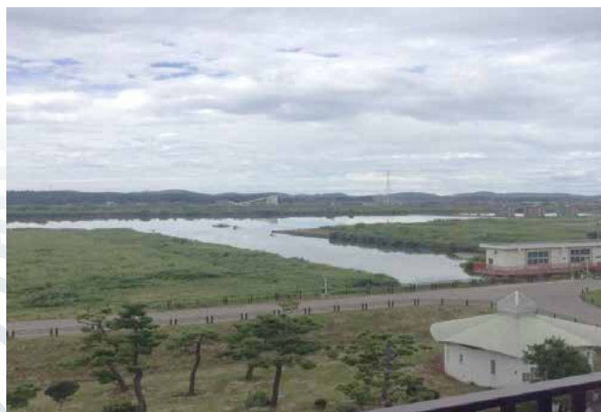
大河津分水路 (新潟県)
