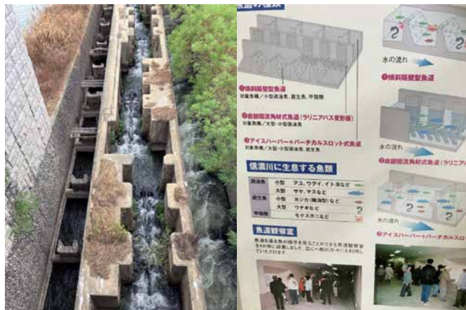
写真12 洗堰に設置された魚道 2023年9月4日
