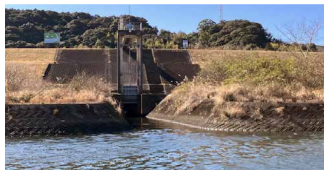
写真2 中央排水処理場の排水口付近の後川；塩素化合物の臭いがする 2024年1月16日著者撮影
