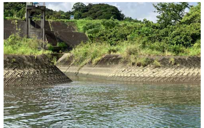
写真5 中央排水処理場の排水口付近の後川；塩素化合物の臭いがする 2023年9月12日著者撮影
