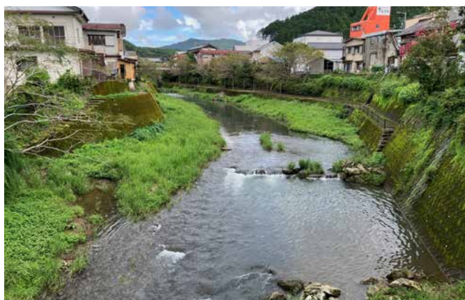
写真10 水量が豊富な状態にある吉見川橋付近の吉見川 2023年9月13日
