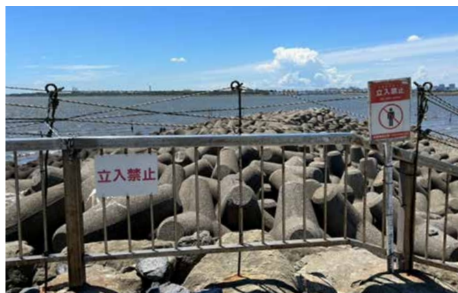
写真4 西なぎさ東側突堤先端部に積み上げられたテトラポッド 2023年8月3日
