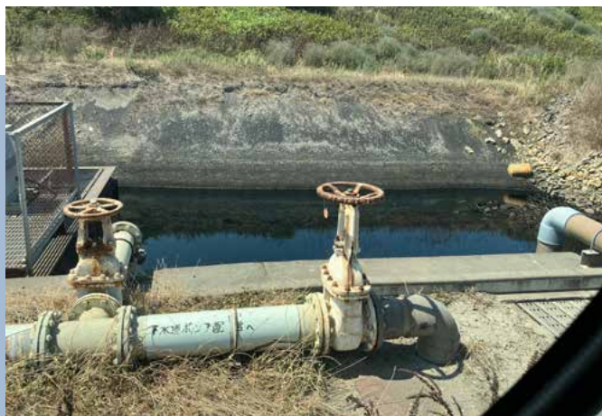
中央堤防外側埋め立処分場
