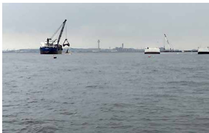
写真1 2023年9月16日午前9時36分 中央堤防外埋め立て地の南端（地点①）で運搬船からヘドロ状態土砂が海洋に投棄される瞬間；著者撮影
