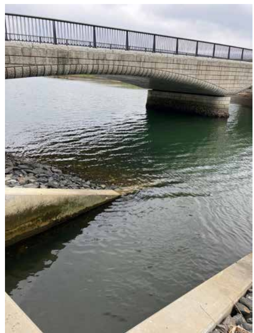
写真3 陸前高田浄化センターの排水口から排水 2023年6月27日
