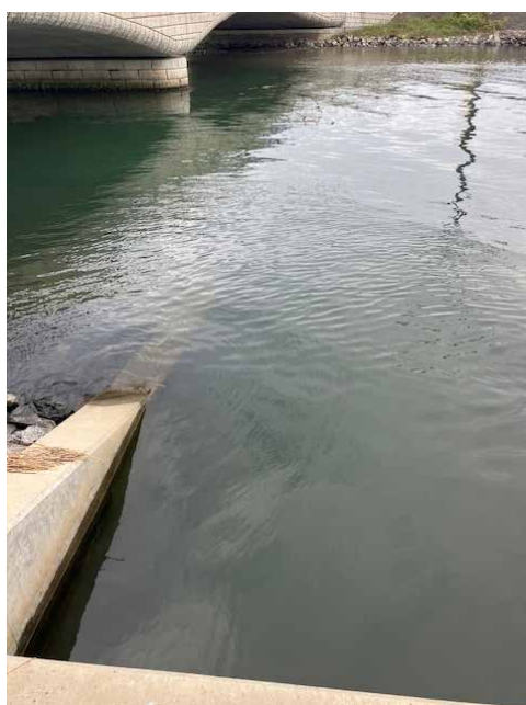
写真8 陸前高田浄化センターの排水口から排水 2023年9月25日
