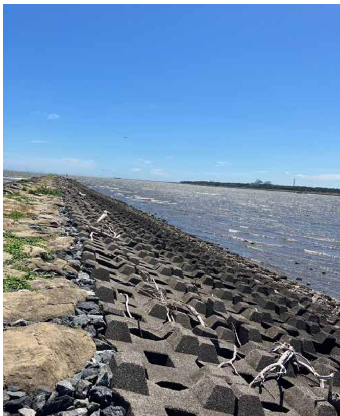
写真6 西干潟の西の突端のRiprapとコンクリート護岸 著者撮影
