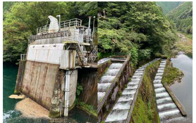
写真5 ごみがたまると定期的に除去 写真6 初瀬ダムのコンクリート魚道 していると四国電力は説明；初瀬ダム 2023年9月13日
