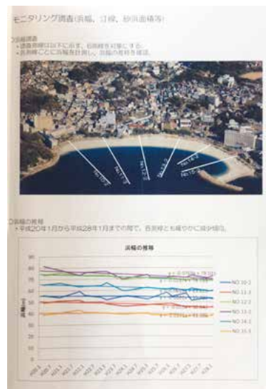
写真3 白良浜の海浜の後退の状況 資料：県土整備部港湾空港局
