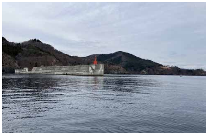
写真2 防波堤開口部から見た湾口防波堤北堤（左） 2023年12月19日
