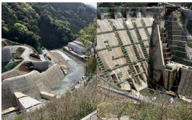
写真9 ダム下流 2023年4月17日
