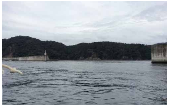
写真2 湾口防波堤北堤(右)外から見た防波堤開口部 左が南堤 2023年6月27日
