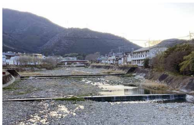
写真8 リッパー掘削をかけた奈良川と堰 堰が水流と土壌流を止めている 2024年1月16日
