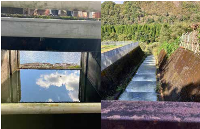
写真5 ダム湖側の魚道の採水口 2023年10月16日
