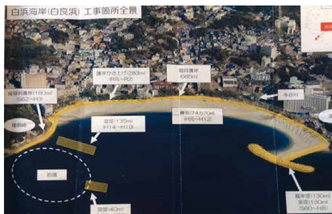
図1 白浜海岸の工事箇所全景 資料：和歌山県県土整備部港湾空港局提供
