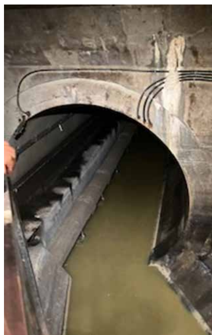
写真6 6.25メートルの内径の下水道管 2023年7月21日 著者撮影
