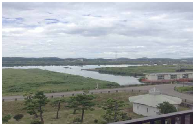
写真1 2022年8月31日信濃川大河津資料館から見た大河津分水路と西川（手前の分流）
