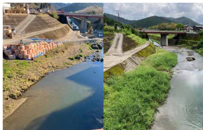
写真13 河川工事が行われた新開橋 2023年2月27日著者撮影
