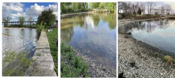
2023年5月3日 Havre de Grace市の護岸(bulkhead)
