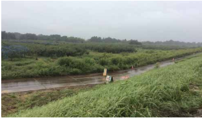
写真4 穂保地区の左岸の堤防修復工事を外側から撮影したもの 2022年9月1日
