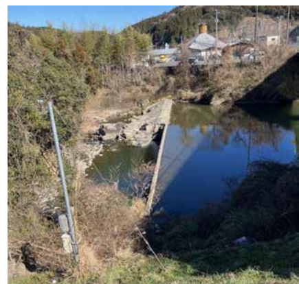
写真8 仁井田川橋の下流の堰を左岸から見たもの 2024年1月17日
