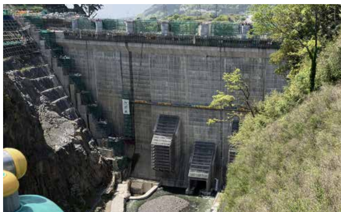
写真2 立野ダムの上流から撮影した通水孔。3つの通水孔が見える。 大きさや設置位置は工学的実験と検証により決定したとの説明であった。 2023年4月17日 著者撮影
