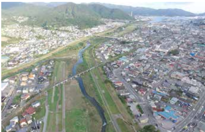
写真 大船渡市内から盛川下流域と大船渡湾を望む 2021年9月
