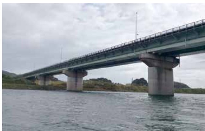
写真3：2021年11月8日 渡川大橋 この橋と四万十川橋（赤鉄橋）との間に岩崎排水口があり、水質が渡川大橋で若干悪化する。
