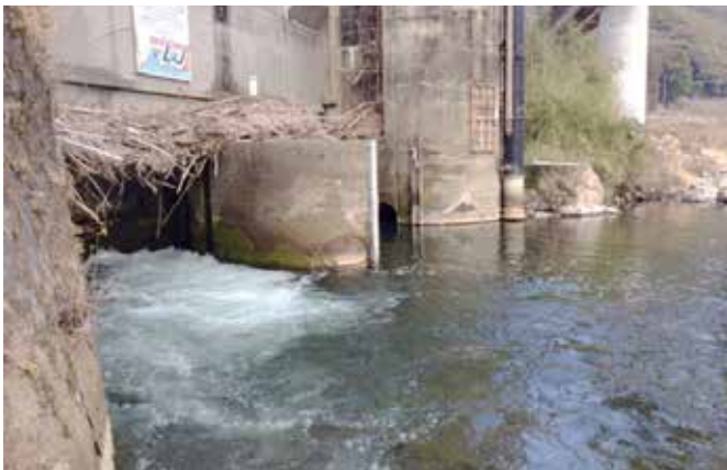
津賀発電所の排水口 2022年3月12日 午後 著者撮影
