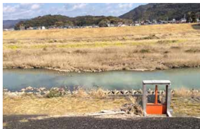
桜町排水機場の排水口と青白色の後川 2022年3月14日
