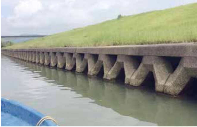
写真3：中筋川下流域のコンクリートで固められた河岸 8月2日筆者撮影
