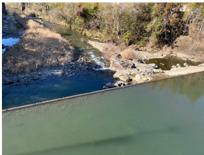
渇水状態の仁井田橋下の堰：水がせき止められ水質悪化傾向を促進。 2023年2月27日
