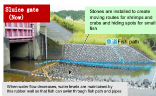
Removal of steps (Kuki Sluice gate)
