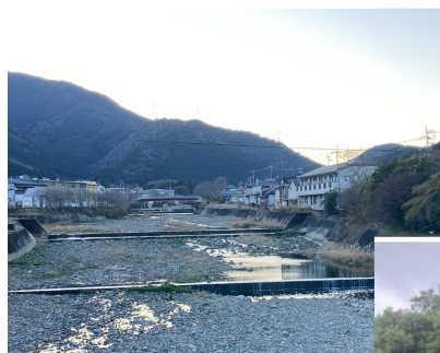
リッパ掘削をかけた奈良川の堰。堰が水流と土砂流を止めている。2024年1月16日
